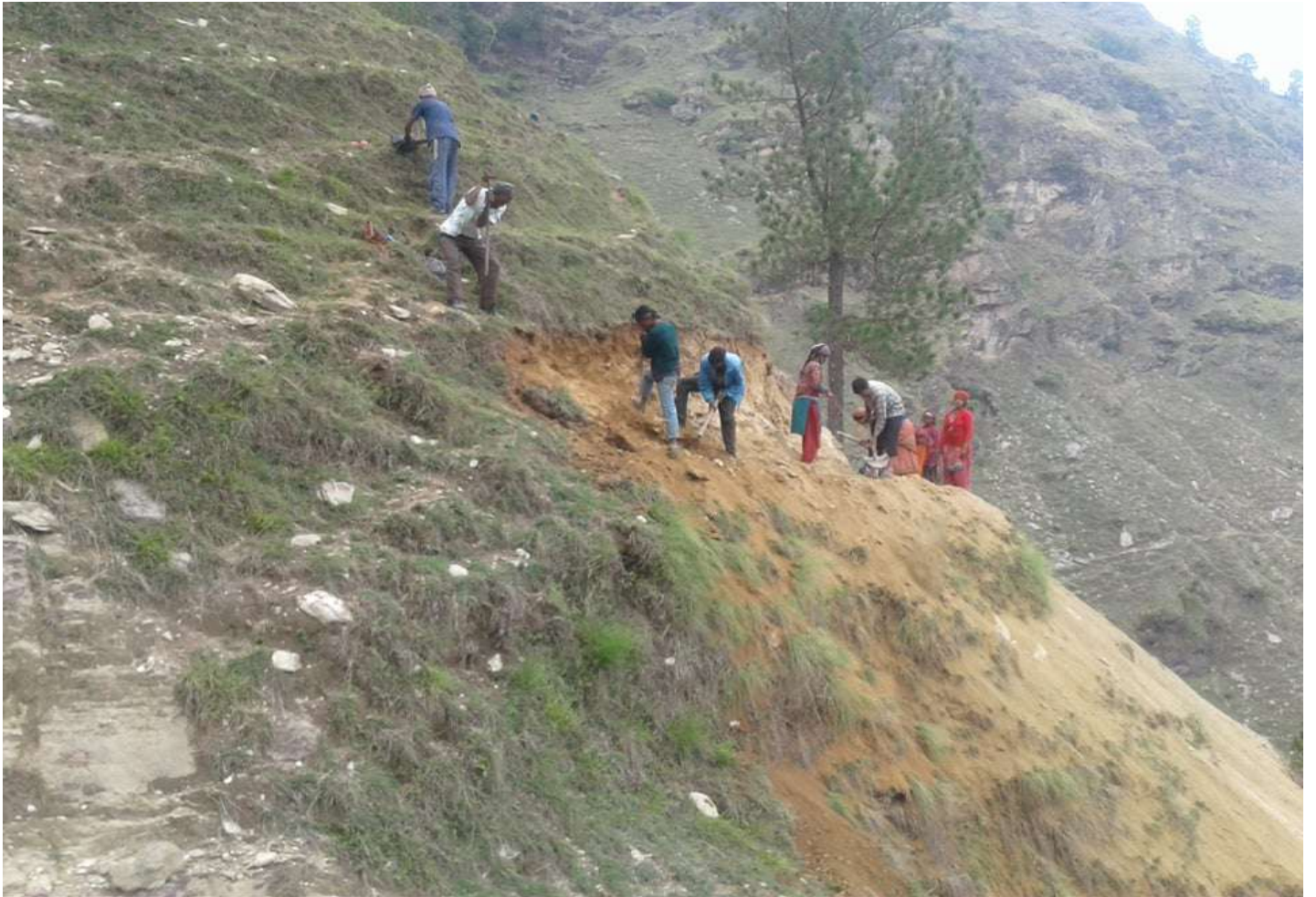
वडा नं. ६ चीपिन अर्न्तगत अल्लेडी देखि गोठि सडक निर्माण कार्य हुँदै गरेको दृश्य ।
