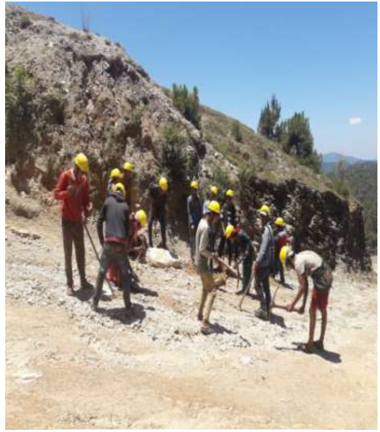
खौलेमा बाटो मर्मतका लागि मा जुटेका श्रमीक टोलि
