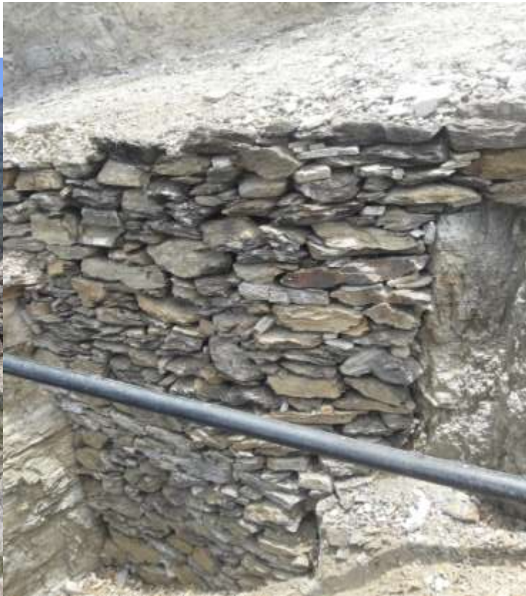
वडा नं. १ खौलेमा पर्ने बाटाको बाँधको फाउन्डेशन मिलाउँदै गरेको काम को चित्र ।
